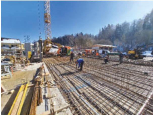
Im Neubau wurde sehr viel Eisen verbaut.
