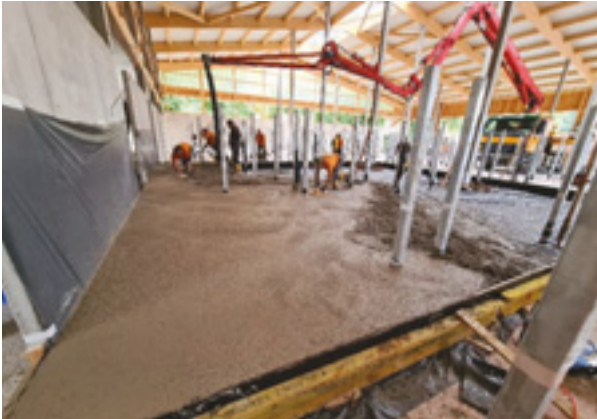
Das Betonieren der Stallfläche
