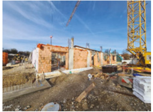
Hier entsteht die neue Versteigerungshalle
