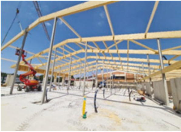
Die Dachkonstruktion wird errichtet
