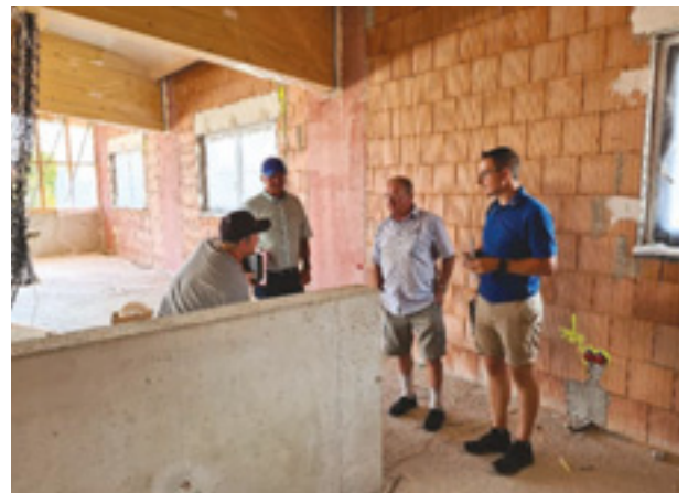
Unsere Baumeister (v.l. Anton Mayer, Ernst Mayer, Hubert Hartl und Adrian Litwin) bei der Baubesprechung.
