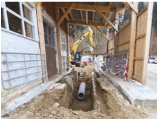
Der neue Kanal wurde schon vorbei an der alten Halle verlegt.
