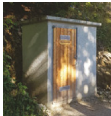
Neues Pumphäuschen am „Eingang“ der Alm
